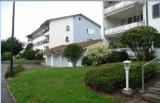
Abb. 3: An einem teilsanierten Mehrfamilienhaus in Zofingen wurde das Energieeinsparpotenzial mit den entsprechenden Amortisationszeiten aufgezeigt
