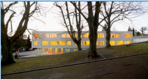
Abb. 1: Ostfassade der Tagesbetreuung «Arche» in Wallisellen
