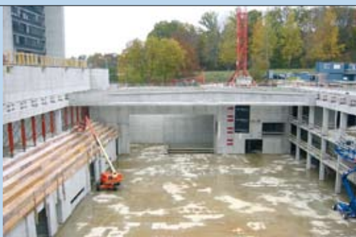
Abb. 1: Rohbau des neuen ETH Sport Centers Hönggerberg.
