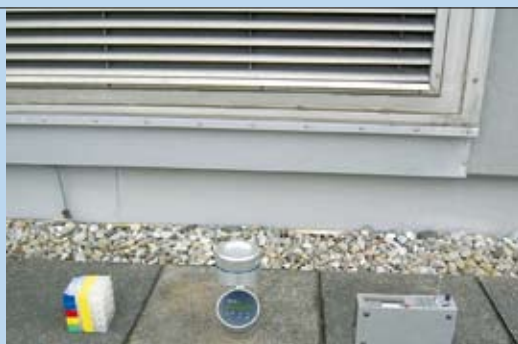
Abb. 2: Keim- und Feinstaubmessungen an der Zuluftfassung.
