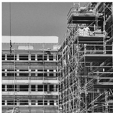
Rohbau: Projekt „Am Eschenpark“ in Zürich-Oerlikon
