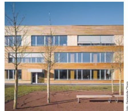
Erstes mit dem GI-Label zertifiziertes Passivhaus in der Schweiz. Schulhaus «Eichmatt» der Gemeinden Hünenberg und Cham.
