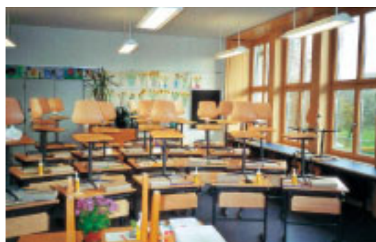
Holzverkleidung der Fassadepartie im Schulzimmer 1
