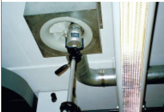
Bild 1: Vorbereitung einer Luftkeimmessung im Zuluftstrom
