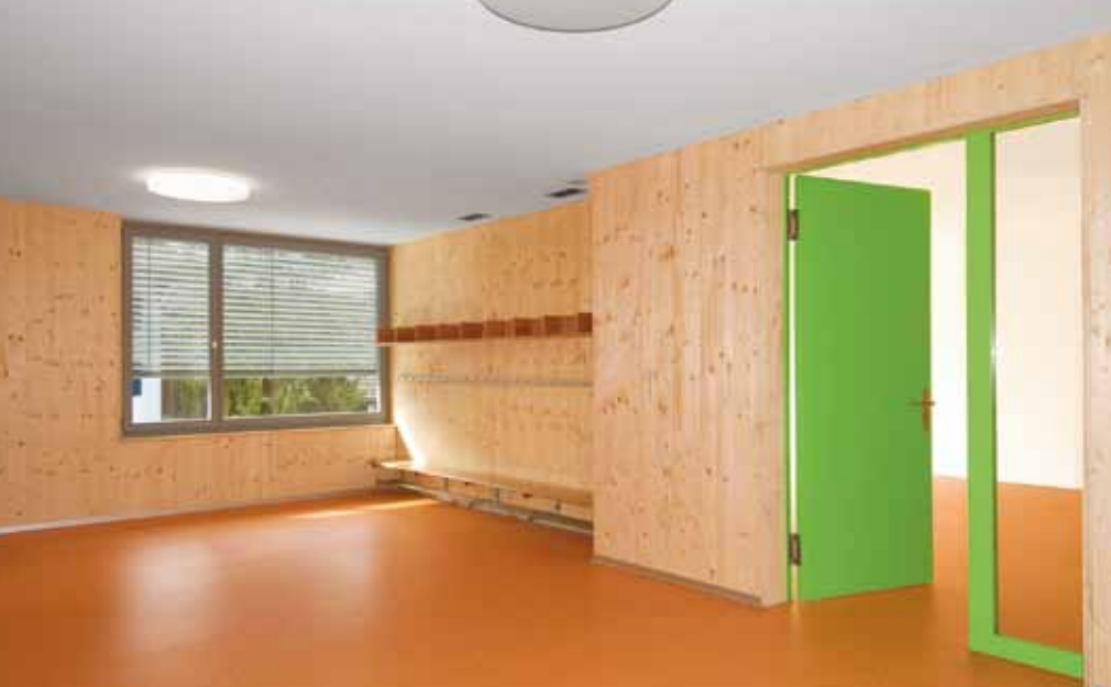
Natureplus-zertifiziert: Linoleum für den Boden sowie unbehandelte 3-Schicht-Platten für die Holzwände.
