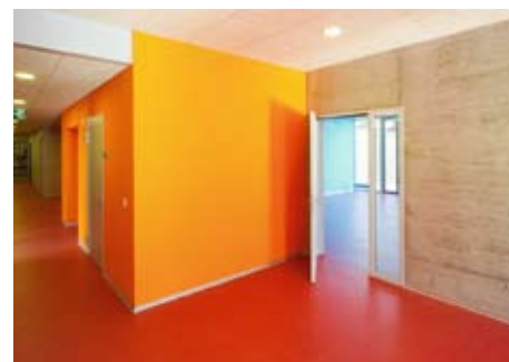
Heruntergehängte Decke mit Gipsfaserplatten.
