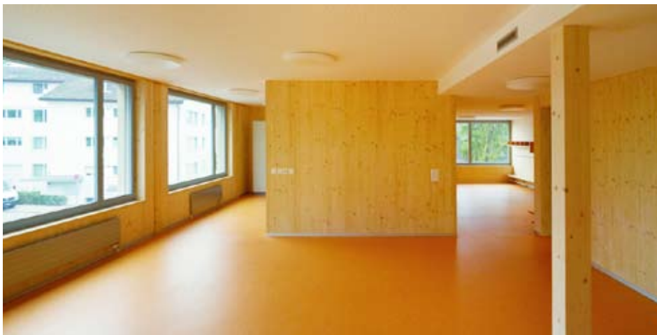
Um den Schall zu dämmen, verbergen sich hinter den Decken Schafwollmatten.
