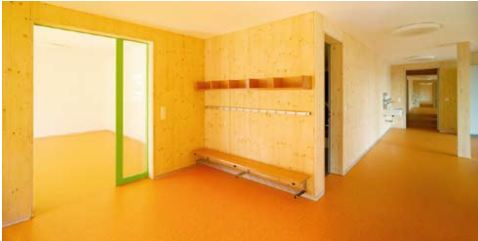
Die Holzwände innen wurden mit 3-Schichtplatten ausgeführt und unbehandelt gelassen.
