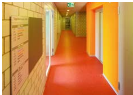
Der Bodenbelag besteht aus Linoleum.
