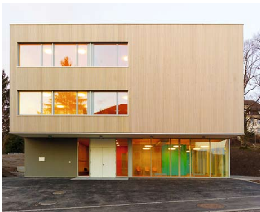
Innerhalb von vier Tagen waren die vorfabrizierten Holzelemente der Arche montiert.
