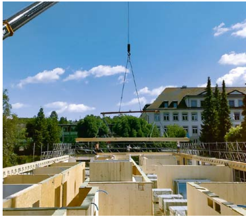
Foto: Zehnder Holz und Bau
